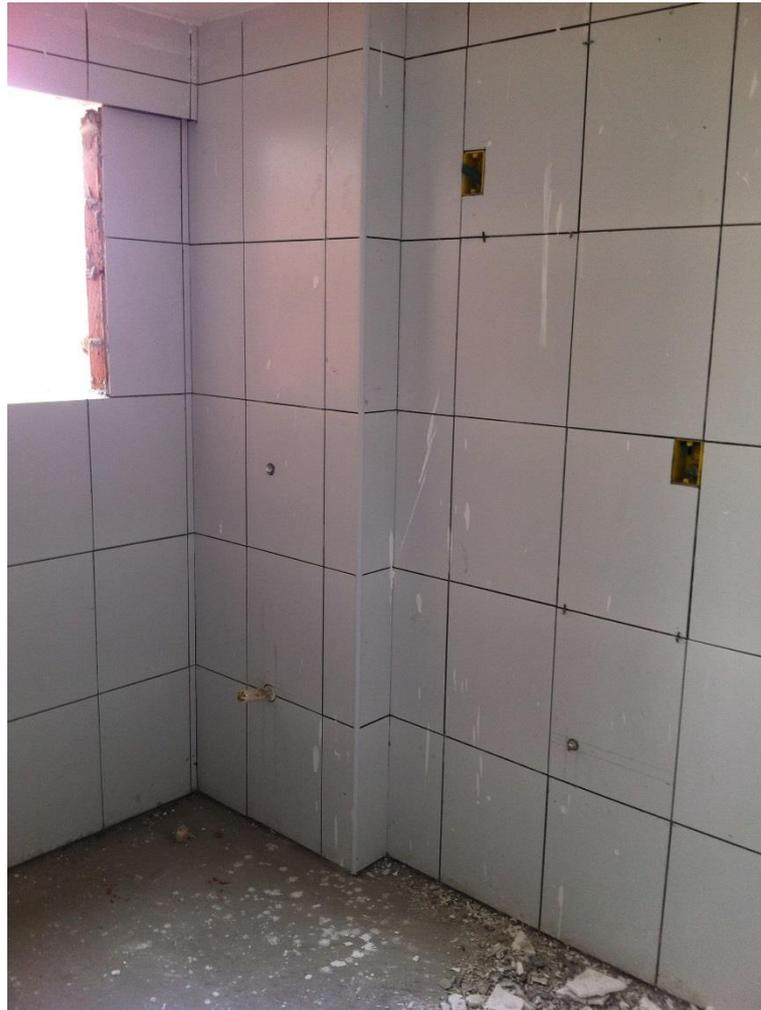
**Figura 6: Revestimento cerâmico na cozinha**
