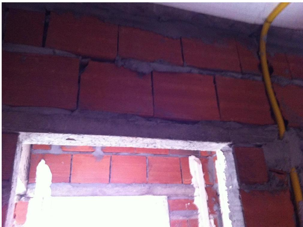
**Figura 4: Irregularidade nas juntas horizontais**
