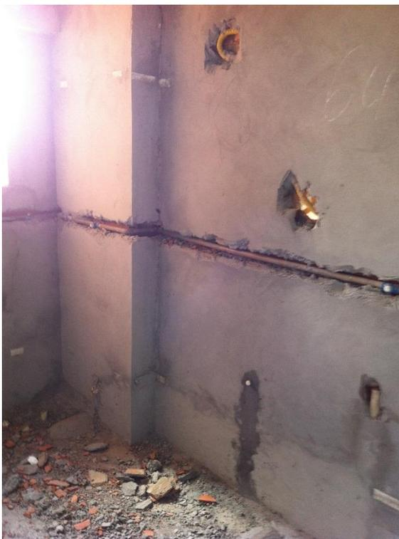
**Figura 5: Revestimento em argamassa executado na cozinha**
